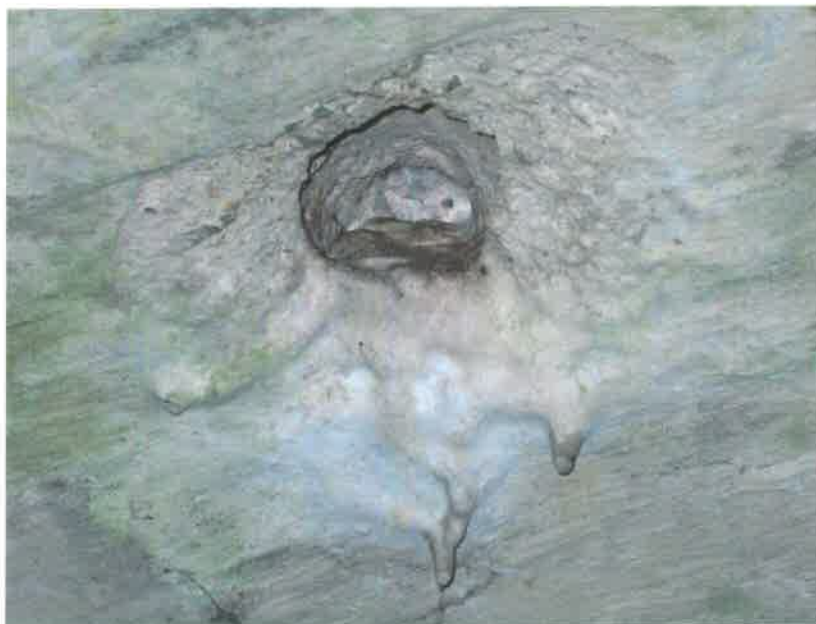
Detail nosné konstrukce s průsaky vody doprovázené krápníčky s výluhy pojiva.
