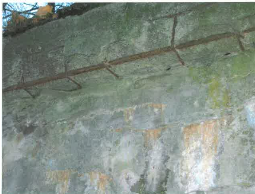
Detail nosné konstrukce-obnažená,korozí silně poškozená výztuž.
